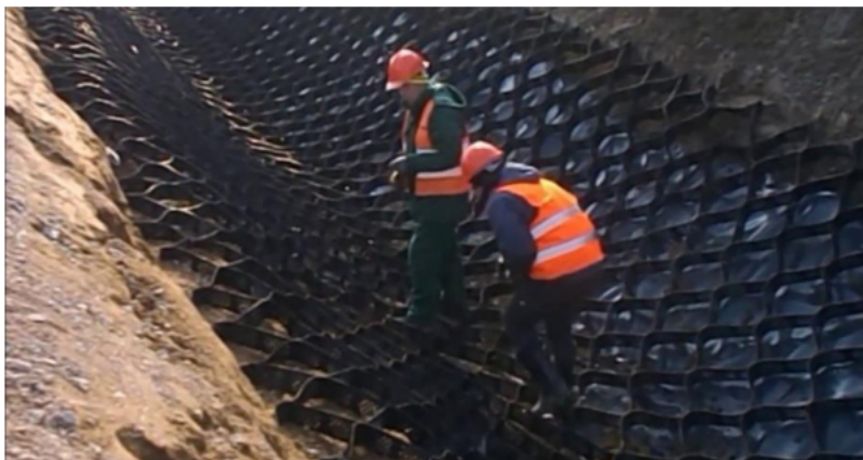
Fotografia 1. Umocnianie dna i skarp rowu materacami geokomórkowymi
