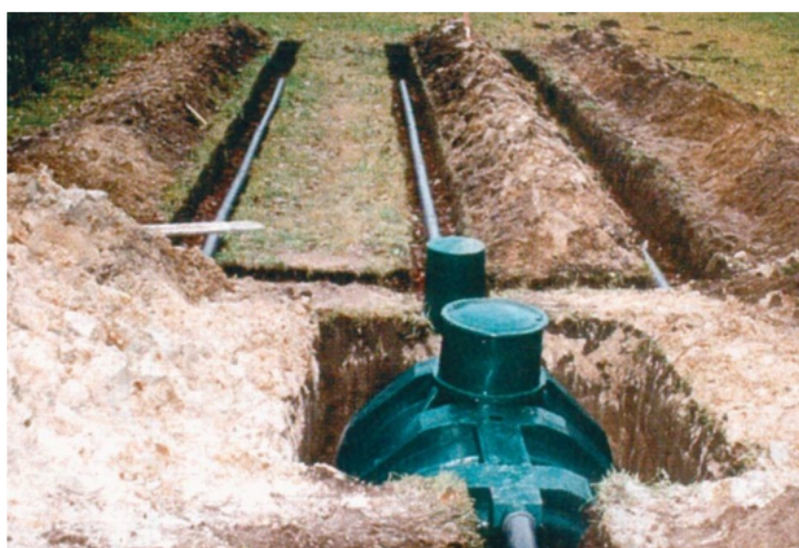
Rys. 3. Oczyszczalnia ścieków w trakcie wykonywania robót budowlanych
