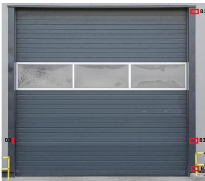
Rysunek 1. Brama przemysłowa z rozmieszczeniem czujników
