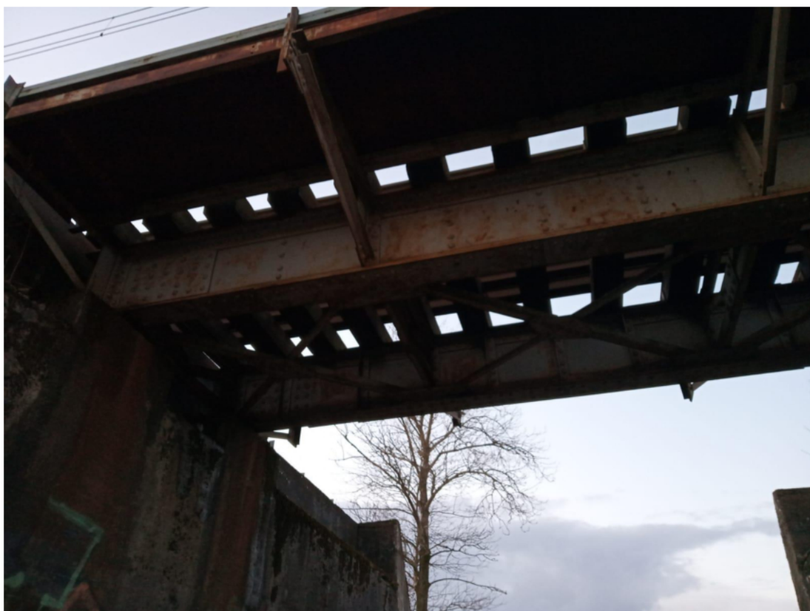
Rysunek 3. Remontowany wiadukt
