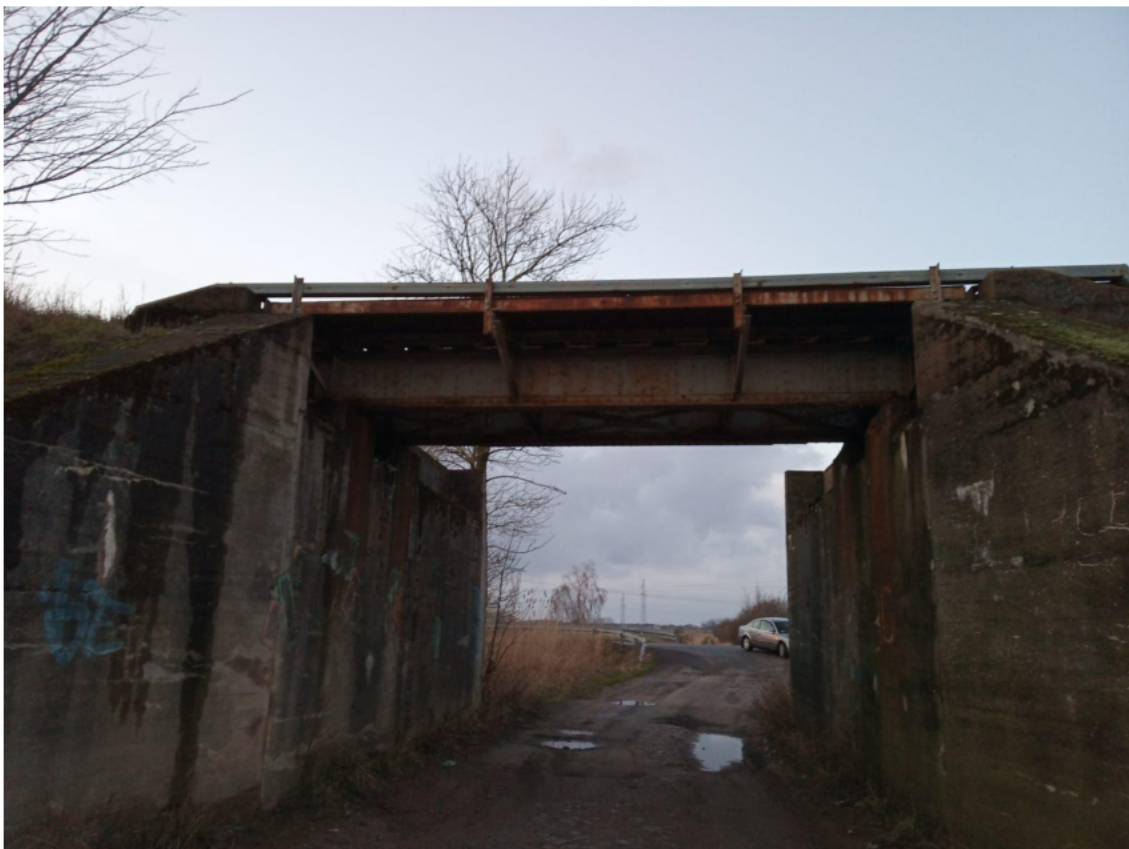
Rysunek 2. Remontowany wiadukt
