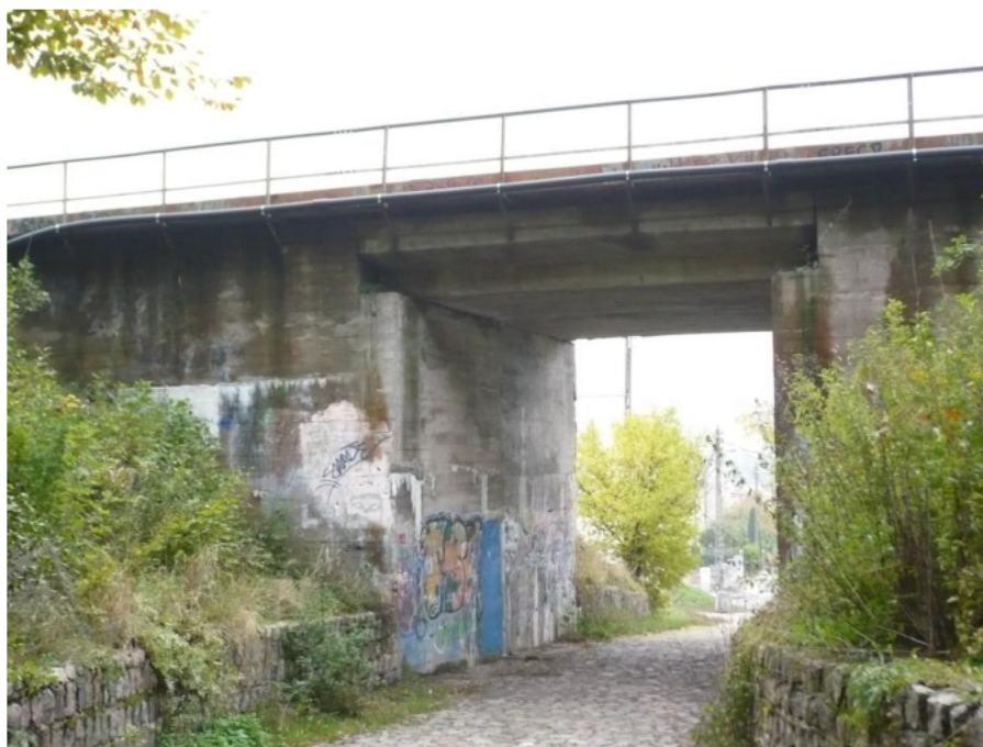
Kolejowy obiekt inżynierski
