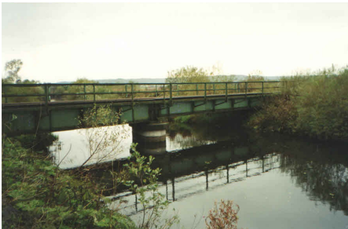
Rysunek 1. Widok remontowanego obiektu
