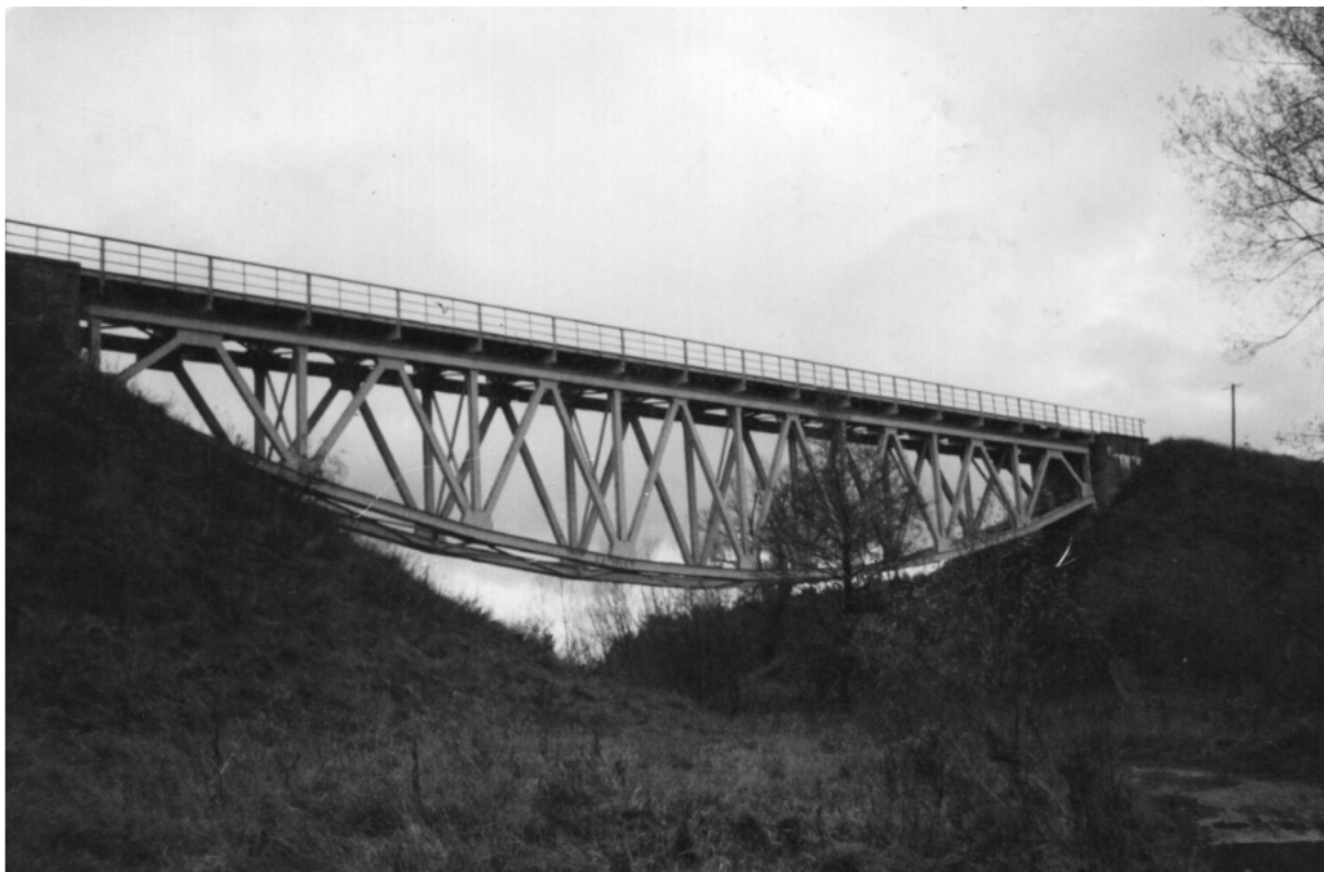
Rysunek 1. Widok mostu kolejowego
