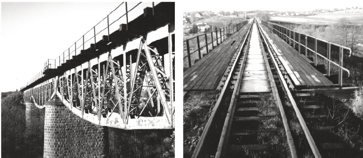
Rysunek 1. Zdjęcia mostu przeznaczonego do remontu
